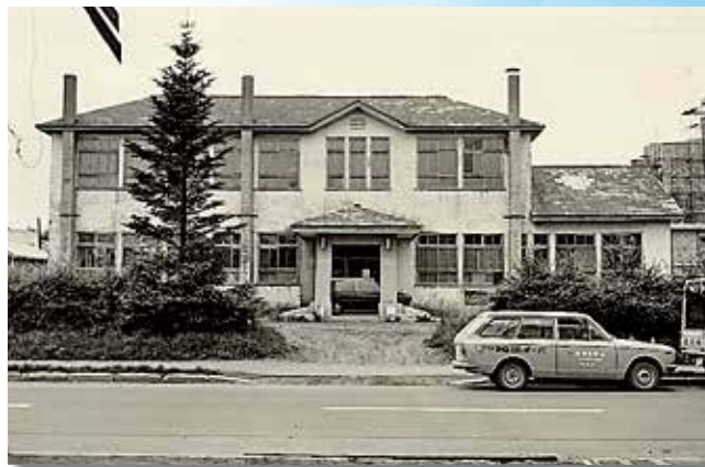
福祉センター(旧標茶保健所庁舎 昭和45年)
